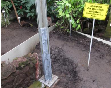
Neue Basis für Gewächshauspfeiler
